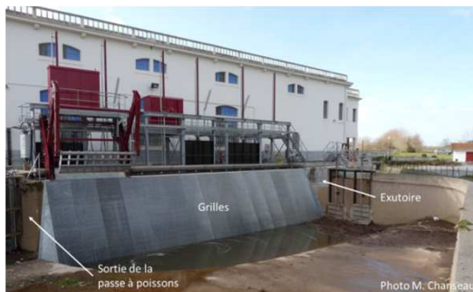
Grille orientée 15°, inclinée à 64° 20mm, 1 exutoire
