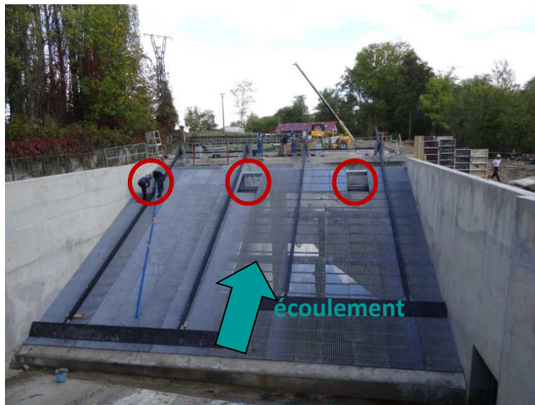
Las Rives (construction)
